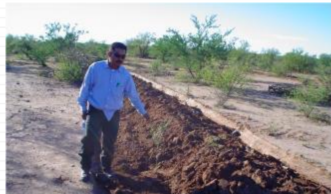
Bordos a nivel construidos con bulldozer. Sonora.
